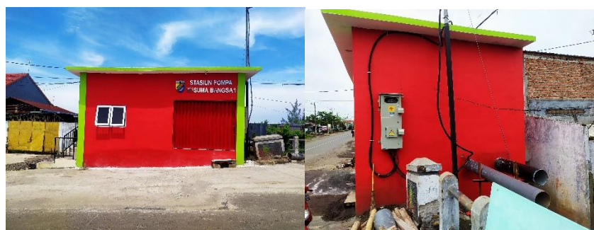
Gambar 4.4. Rumah Pompa 1 Kusuma Bangsa
