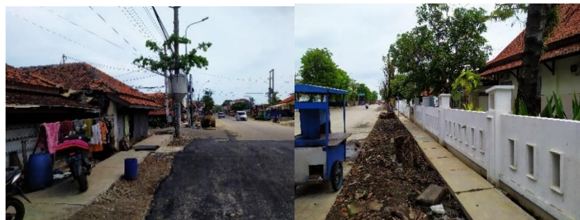
Gambar 4.2. Pembangunan Saluran Drainase (Jalan WR. Supratman Ruas 1)
