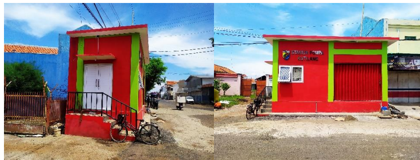
Gambar 4.6. Rumah Pompa Kutilang
