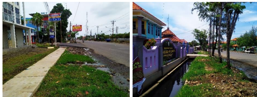
Gambar 4.1. Pembangunan Saluran Drainase (Jalan Kusuma Bangsa)
