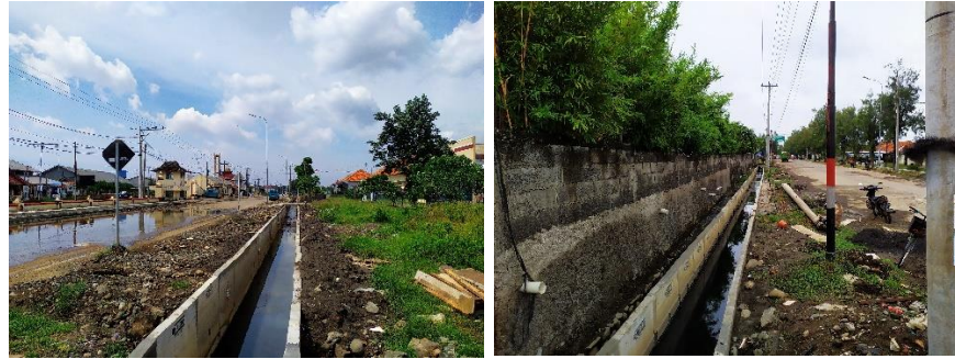
Gambar 4.3. Pembangunan Saluran Drainase (Jalan WR. Supratman Ruas 2)
