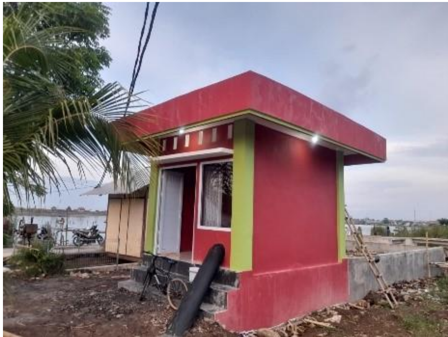
Gambar 2.47. Pembangunan Pompa Kramatsari
