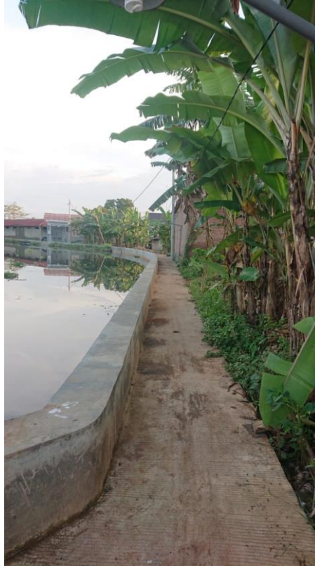
Gambar 2.49. Pembangunan Tanggul Tirto Bremi
