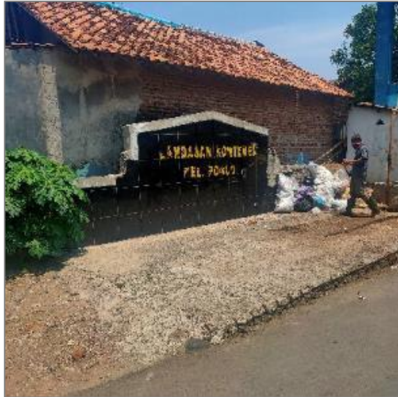
Gambar 2.62. Kondisi TPS Pongcol Kota Pekalongan
